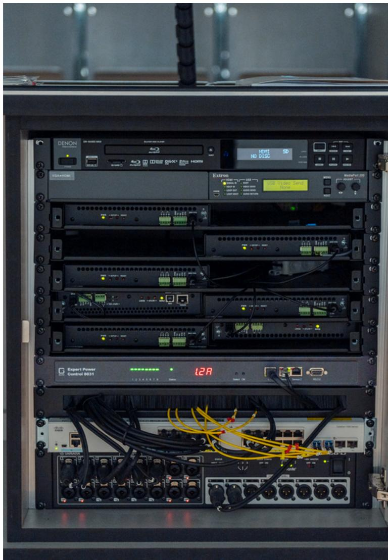
*Expert Power Control 8031-1 steuert und überwacht die Stromversorgung im 19-Zoll-Rack im Pult des Hörsaals
