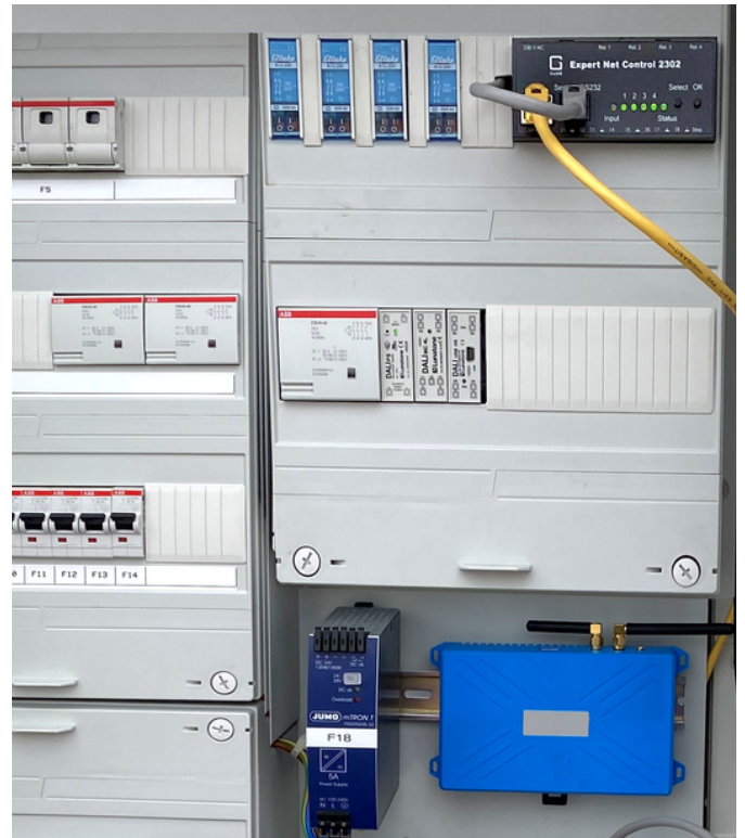
Expert Net Control 2302 im Schaltschrank (rechts oben im Bild), Foto: Stadt Monheim
